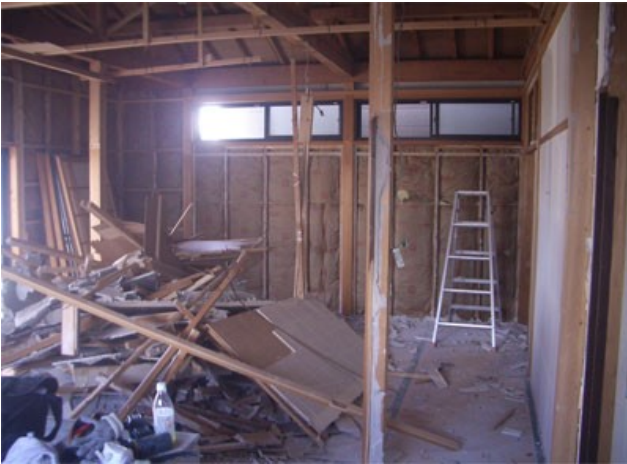
・真夏の解体工事でガリガリに痩せたり…
