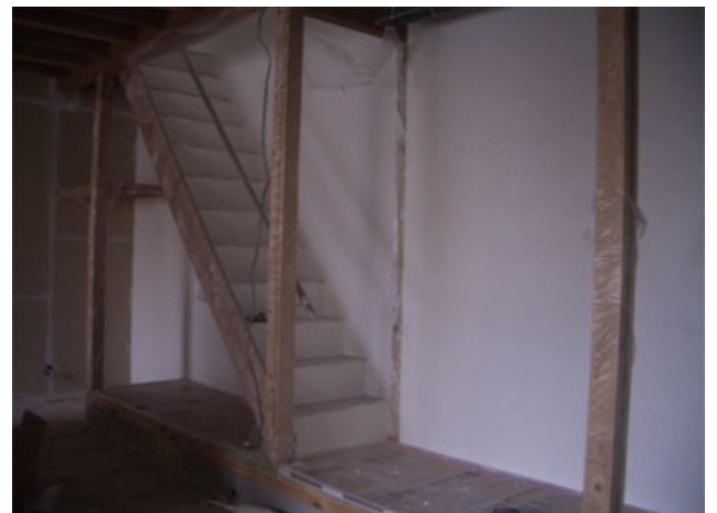
・左官(漆喰)工事も行いました。
