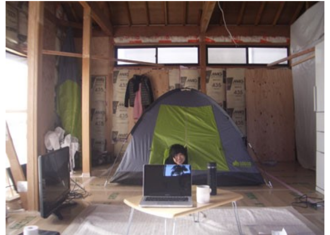
・間に合わなくなって工事中に住み始めたり…
